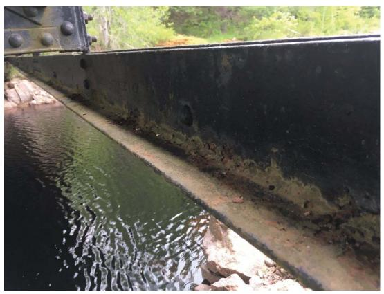
Photo 12 - CORROSION ON TOP SURFACE OF BOTTOM TRUSS CHORD
