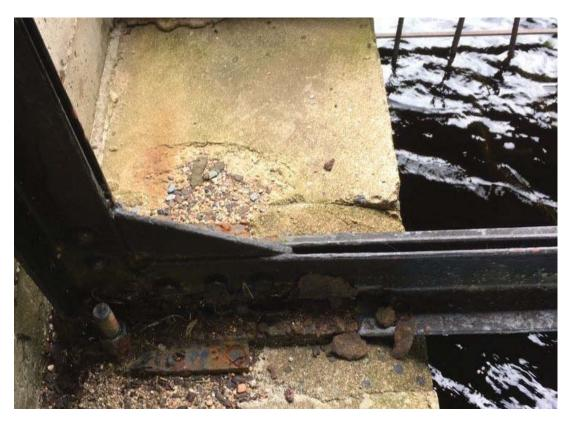
**Photo 8** - SECTION LOSS AT SE TRUSS BEARING
