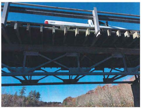
Photo 16 - TYPICAL UNDERSIDE OF TRUSS
