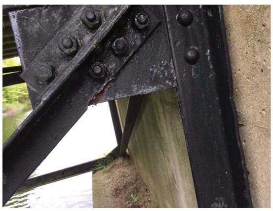
**Photo 12** - TYPICAL PACK RUST AT CONNECTIONS
