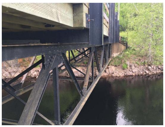
**Photo 4** - PARTIAL N. ELEVATION SHOWING REINFORCED TRUSS MEMBERS
