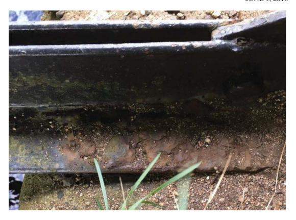
Photo 7 - SECTION LOSS AT NE TRUSS BEARING
